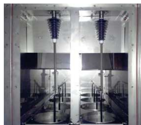
Électrodes d'un électrofiltre OekoRona
